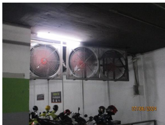
รูปที่ 3-10 เครื่องระบายอากาศในพื้นที่จอดรถ
